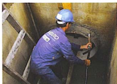
Grante fixa nova tubulação e reestrutura instalação
