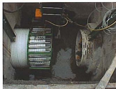
Produção contínua: recuperação sem escavações
