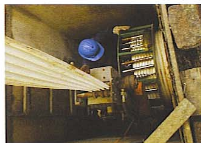
Produção e inserção do tubo Rib Loc na rede existente
