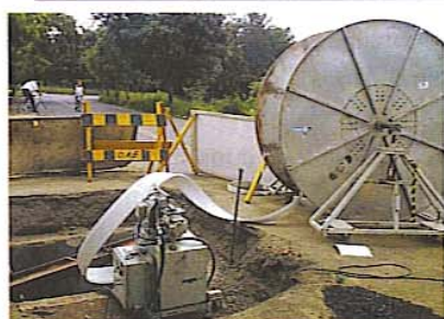
Bobina do perfil de PVC ao lado do poço de visita
