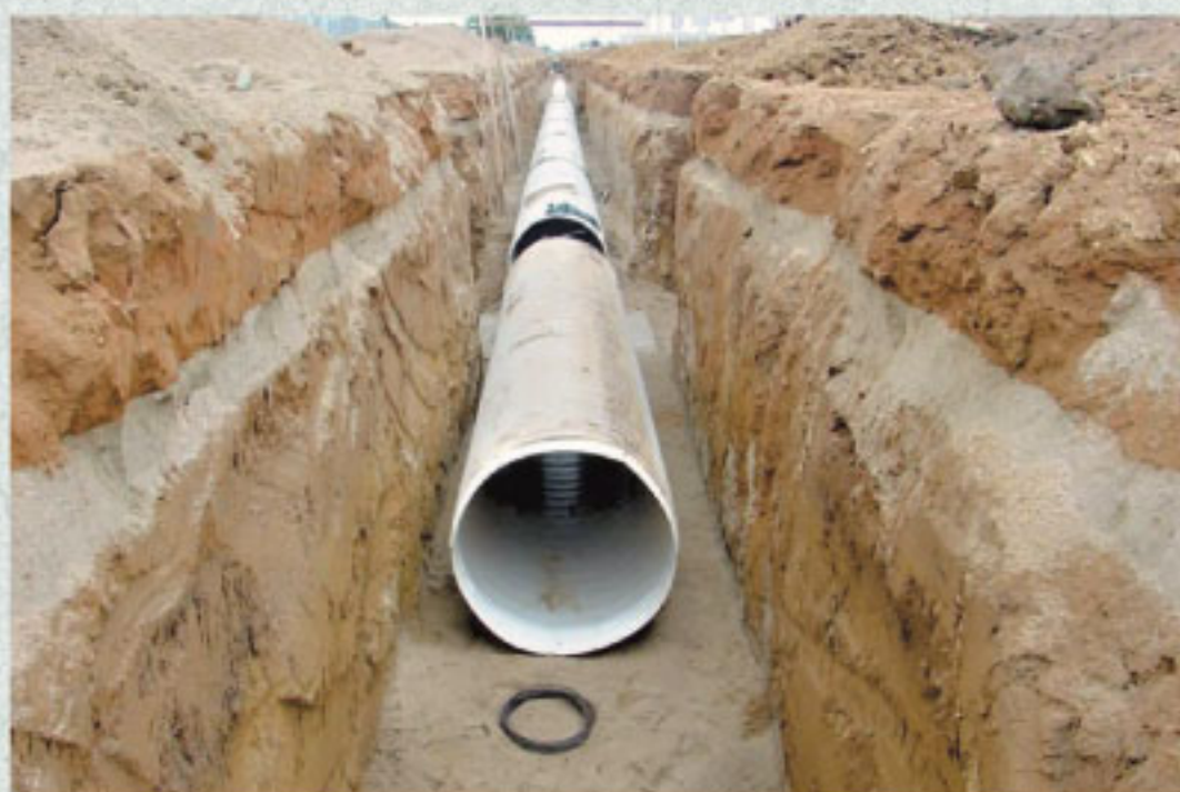
Estrutura tubular: alternativa para sistemas de drenagem superficial e de grotas em áreas urbanas e rodoviárias
