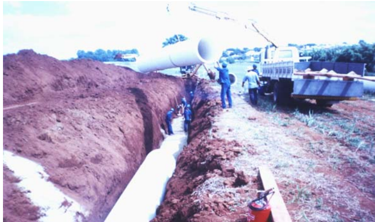
Foto 3 – Transporte e Assentamento dos Tubos
