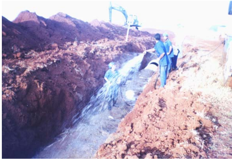
Foto 7 – Aterro dos Tubos
