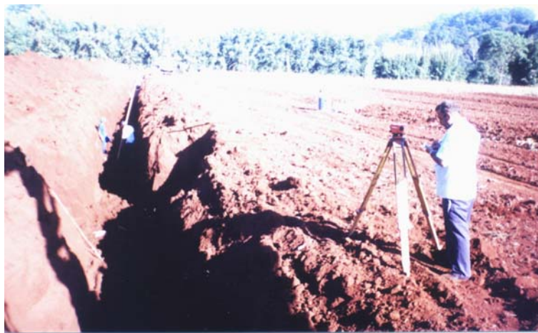
Foto 6 – Fiscalização Topográfica da Obra
